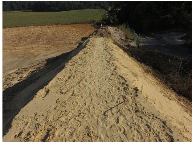
Zone 0, Pente d'accès au merlon sans dépôts
