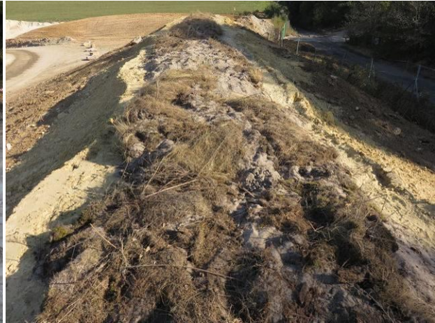
Zone de dépôt 02 vers le nord après dépôt des plaques
