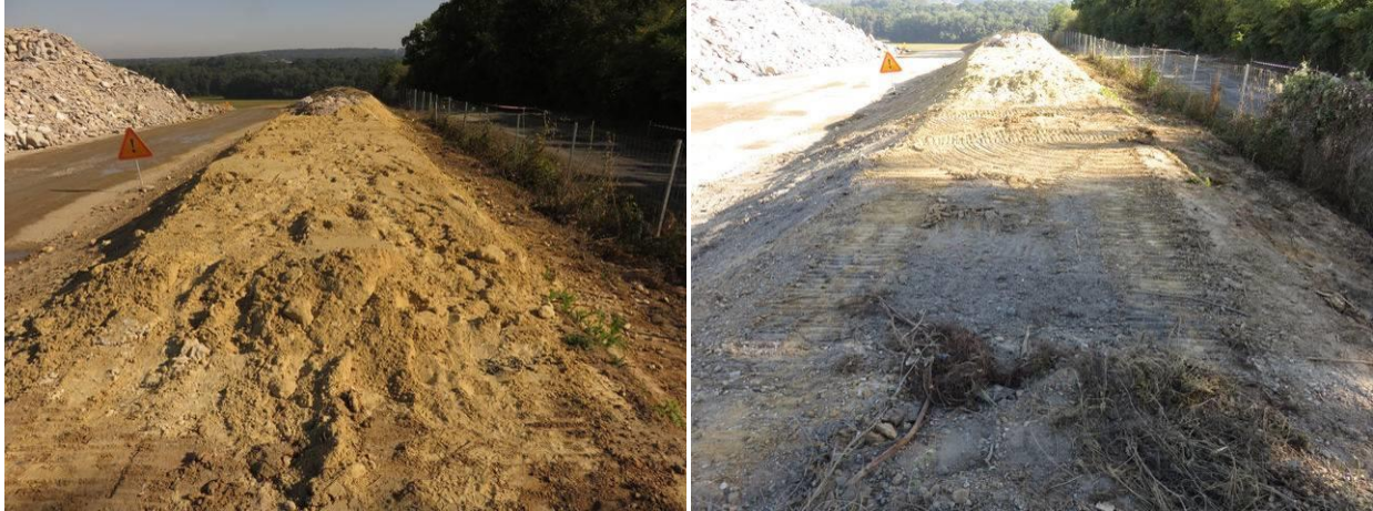
Zone 04 de séparation
